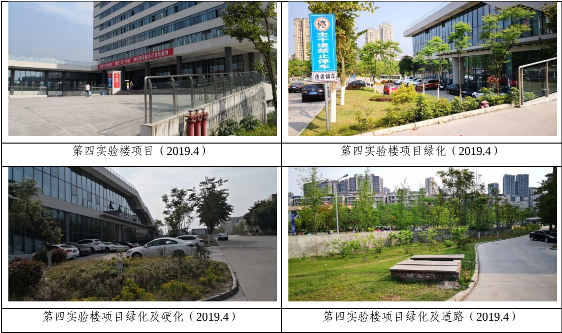
图 1.1-1 第四实验楼项目现状照片
