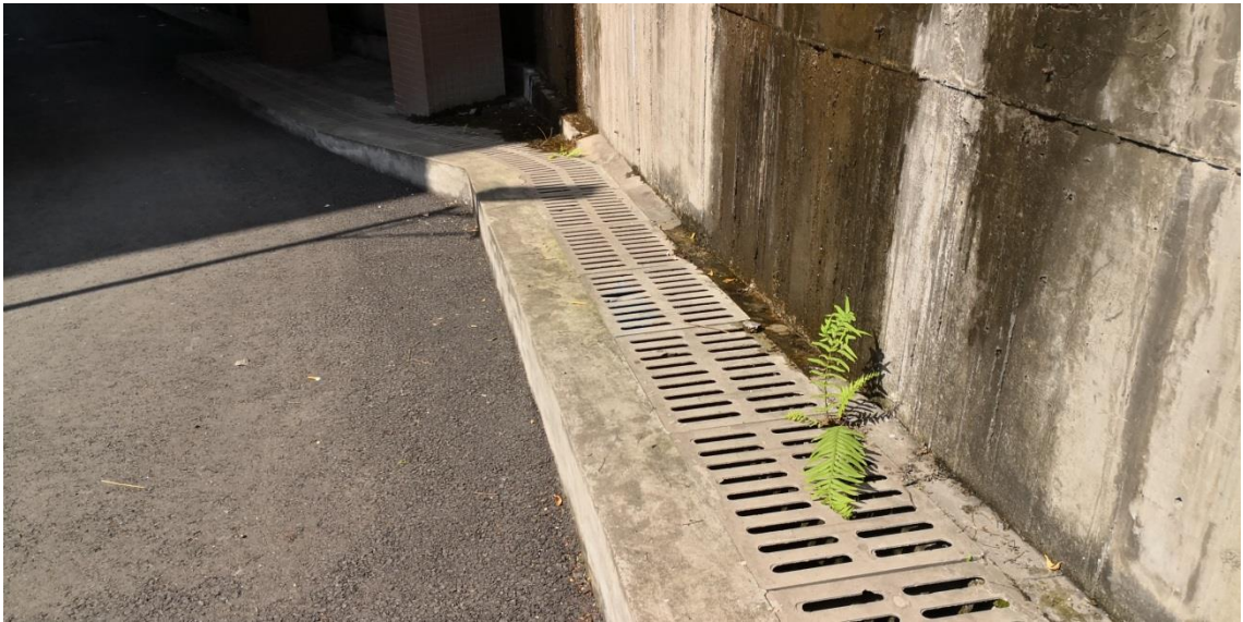
挡墙-墙脚排水沟
