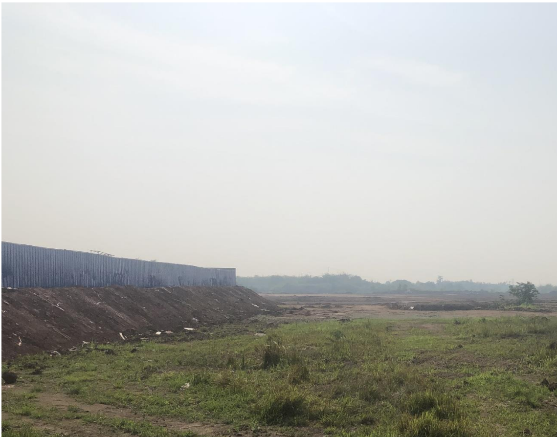
临时弃渣场区渣土回填后植草绿化（2019 年 4 月），后续将进行厂房建设
