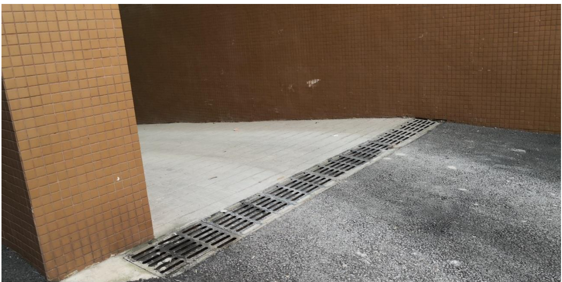
地下车库出入口排水沟
